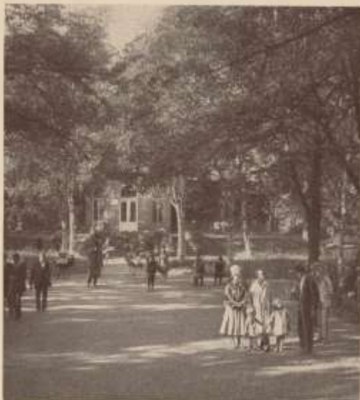
Trinkhalle im Kurpark.
