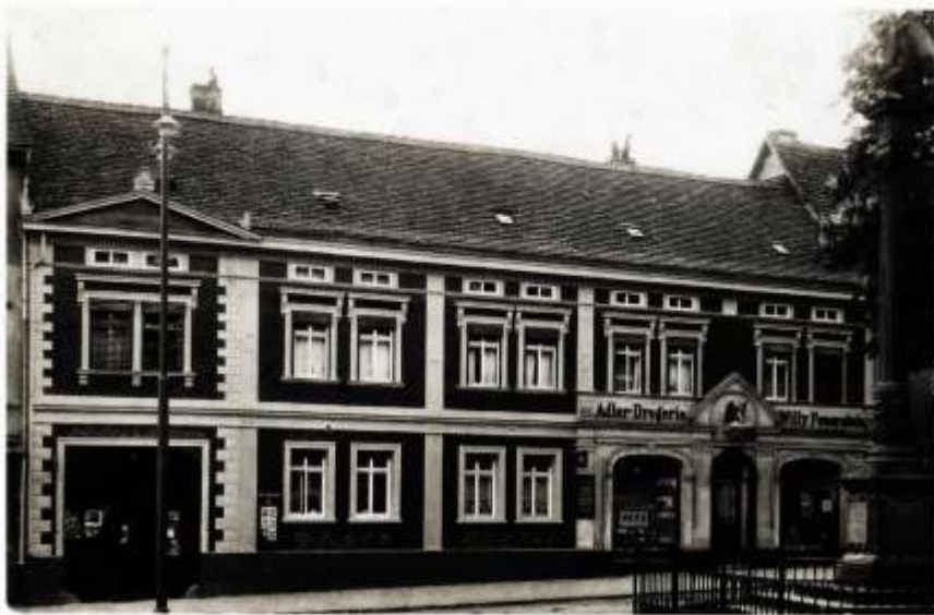
Die „Adler-Drogerie“ mit der alten, heute stark veränderten Fassadengestaltung in der Unteren Marktstraße um 1932. Auf der rechten Bildseite das Kriegerdenkmal von 1871.
