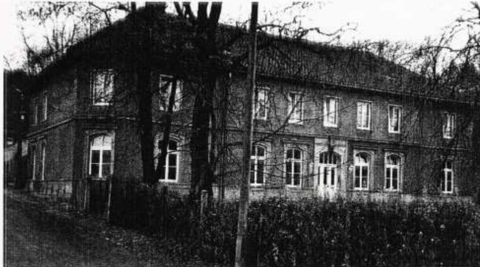
Ehemaliges Hauptgebäude des Konzentrationslagers Bad Sulza, 1999, (Foto: Günter Kaspaul)
