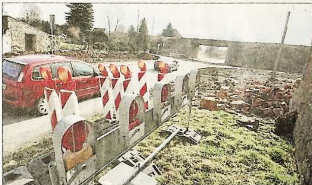
Am Dienstag sollen die Arbeiten an der Bahnüberführung in Darnstedt beginnen. Auf dem Grundstück (rechts im Bild) soll der künftige Brückenkörper vorgefertigt werden und anschließend unter die Gleise geschoben werden. Foto: Sascha Margon
