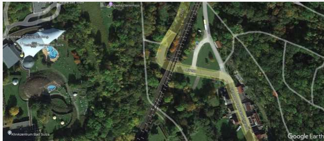
Die Eisenbahnbrücke über die L2158 nach Dorfsulza 2022
