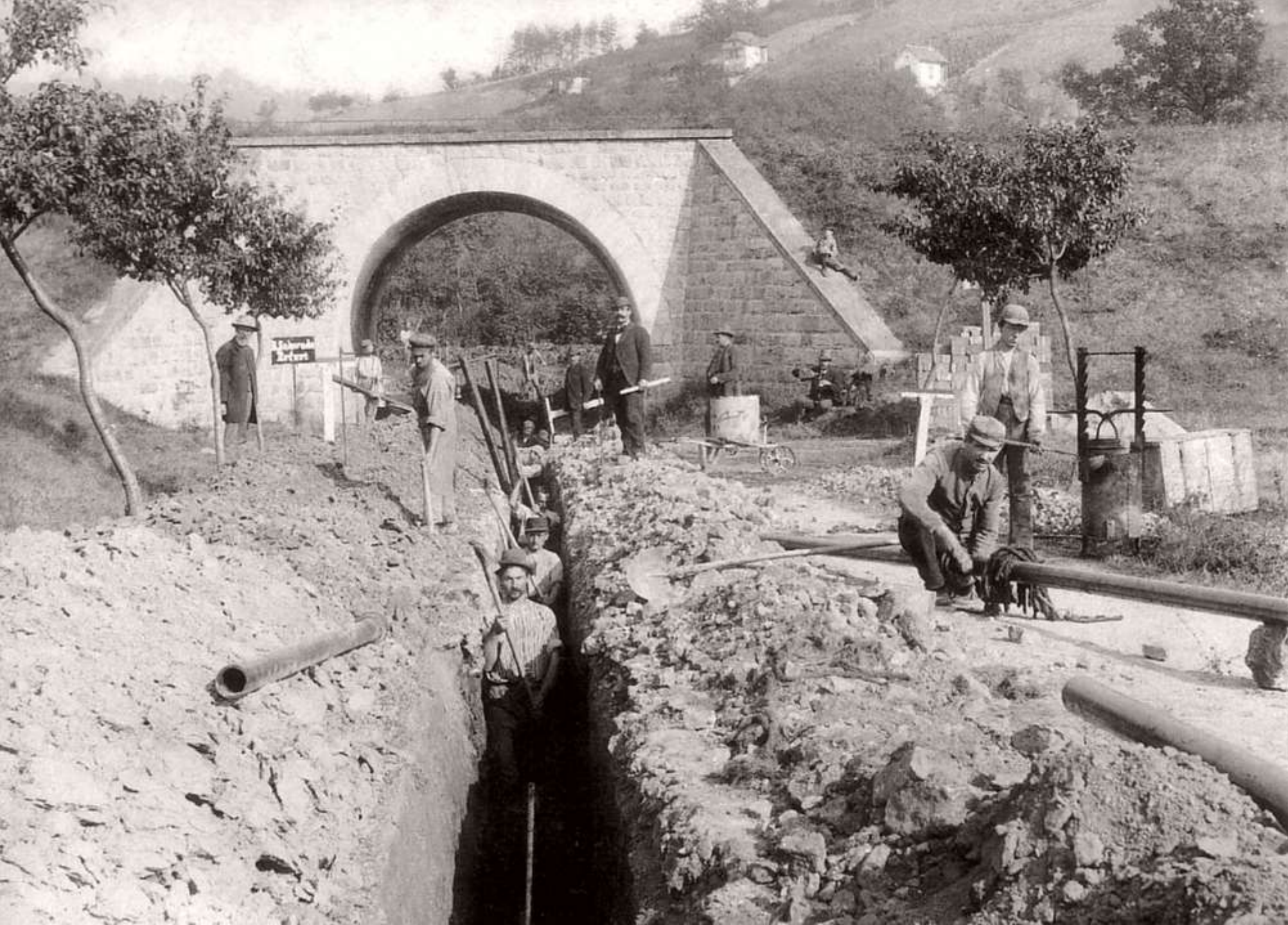
Wasserleitungsbau unter der Bahnbrücke nach Dorfsulza um 1895
