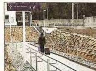
Die rollstuhlgerechte Rampe zur Bahnunterführung hin wurde mit städtischen Mitteln und Fördergeld finanziert. Baubeginn für alles war im August 2015.
