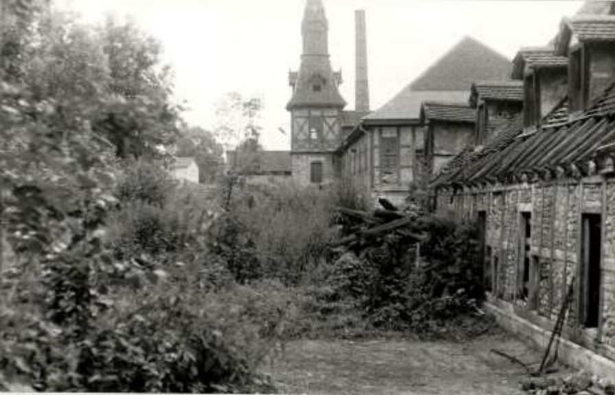
Hof hinter dem Siedehaus 5 nach teilweiser Beräumung.
