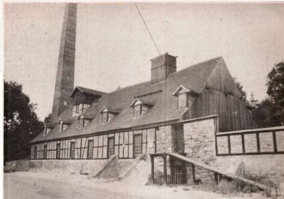
Das Siedehaus 5 (unser Bild) der ehemaligen Saline Bad Sulza zeigt sich innen und auch außen wieder in seiner ursprünglichen Form. Fassade, Fenster sowie das Dach mit den Goußen und Entlüftungsschucht wurden zum größten Teil originalgetreu, wie in der Mitte des 18. Jahrhunderts erbaut, wieder hergestellt. Vom Siedehaus 4 (auf unserem Bild der rechte Abschnitt) blieben nur noch die Grundmauern erhalten. Hier soll künftig auch noch gebaut werden. Museumsräume und sanitäre Anlagen sind dort vorgesehen.
